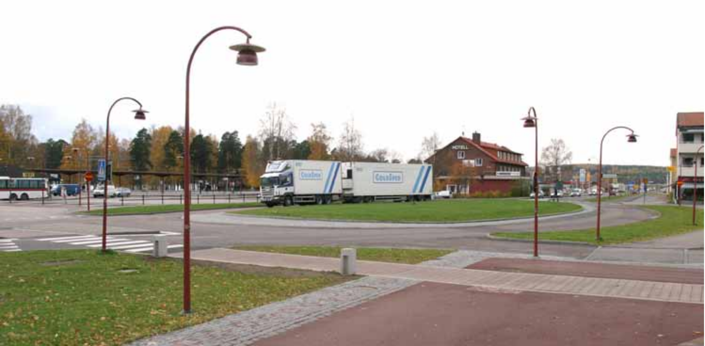
Den ovala rondellen löste problemet med flera utfarter från samma sida av riksvägen.
