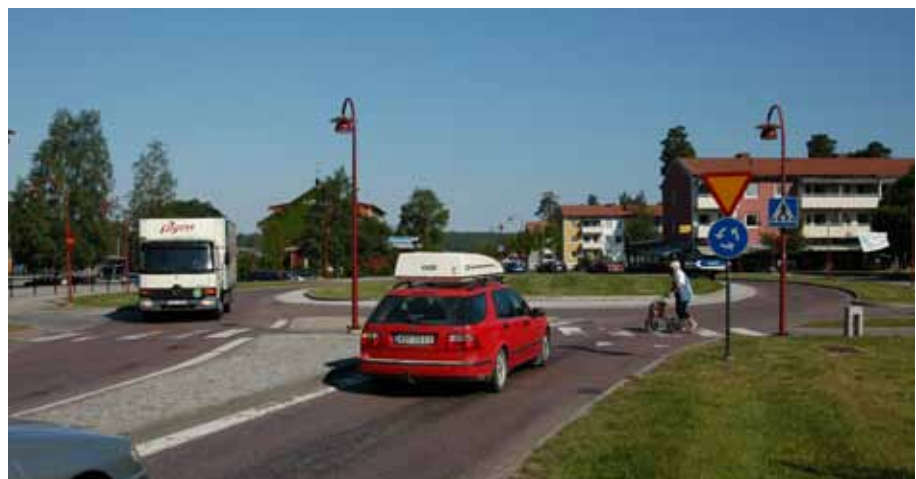
Rättviks centrum i dag: Rondeller har ersatt trafikljusen och hela genomfarten har blivit mer överskådlig, säkrare samt mer tillgänglig för alla trafikslag.
