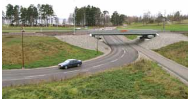
Vägporten under järnvägen fick en nättare utformning än de som Banverket annars brukar bygga.
